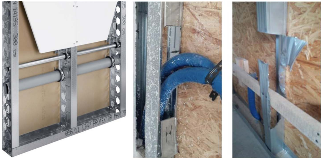
Abbildung 3: Eine ausgeklügelte Schnittgeometrie inklusive Faltechnik führen zu Aussparungen im Profil, die Material sparen und gleichzeitig die Statik erhalten
